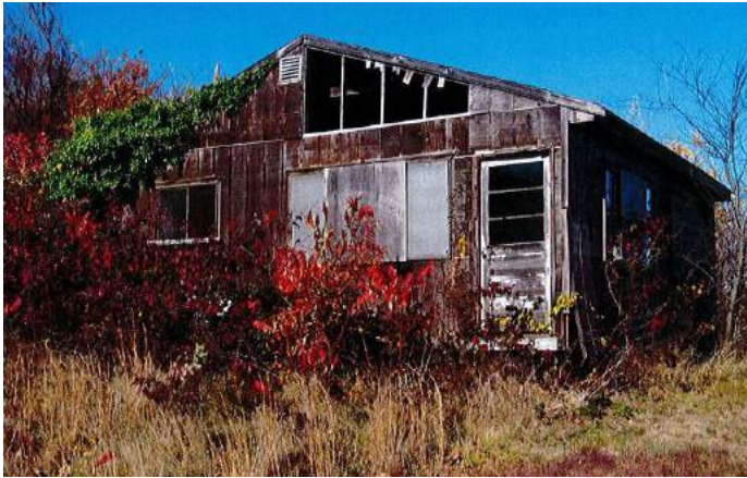
S. elevation of Cottage 09.
